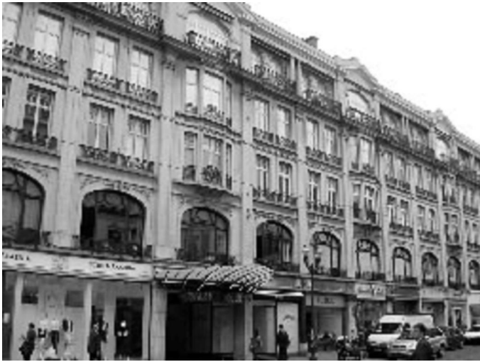
Vue sur le n°32-46a de l'avenue Louise : un immeuble prestigieux dans un parfait état, prêt à être reconverti en logements...
