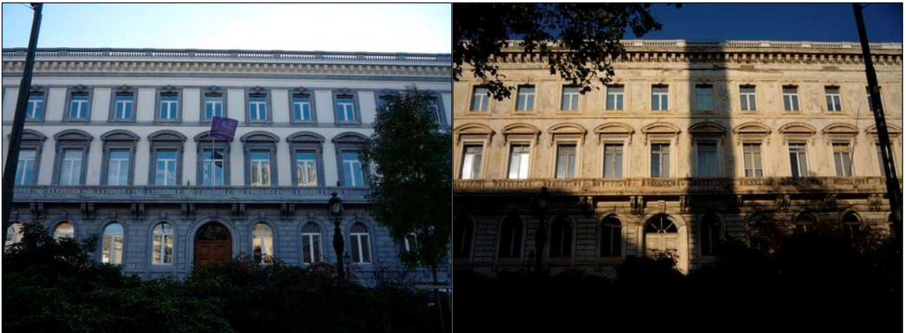
Les deux bâtiments néoclassiques de la place du Congrès : tous deux classés ils étaient à leur construction parfaitement identiques
