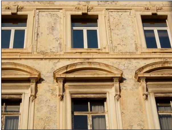
La façade de l'ISIB tombe en morceaux qui se retrouvent sur un filet de sécurité quand ce n'est pas par terre
