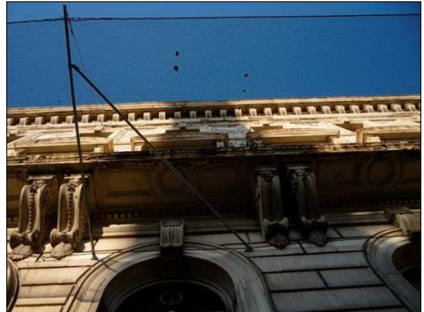
La façade de l'ISIB tombe en morceaux qui se retrouvent sur un filet de sécurité quand ce n'est pas par terre
