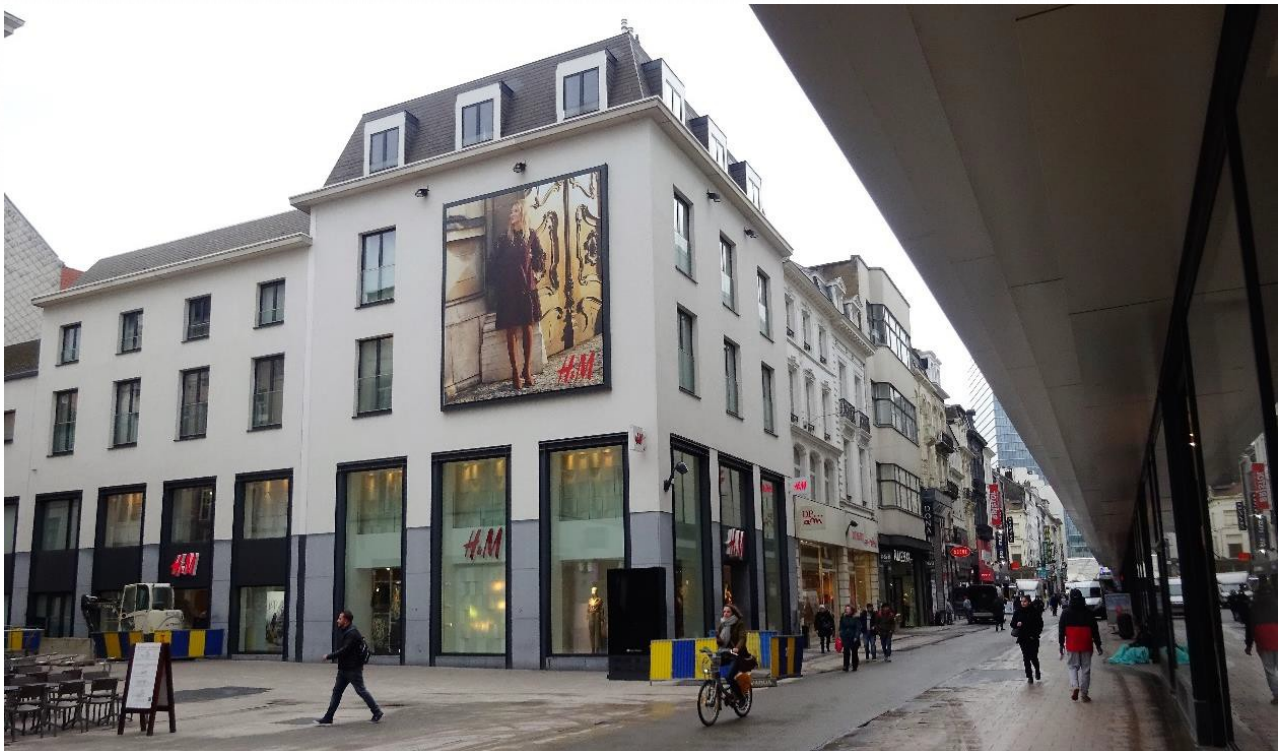
Les immeubles concernés par le projet : tout est voué à la démolition excepté les façades des 2 maisons à droite du H&M (source : rapport d'incidences, Aries)
