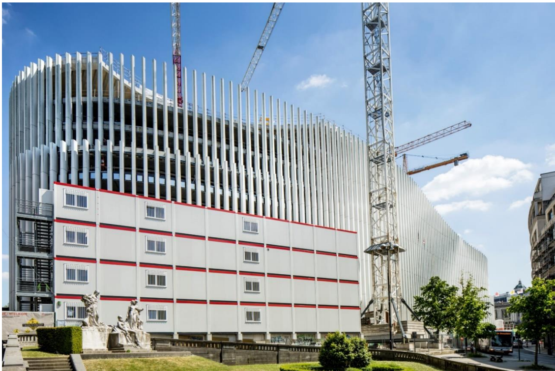
Le chantier de construction du nouveau siège de BNP Paribas Fortis, récemment inauguré. Il s'agit d'une opération de démolition- reconstruction.
