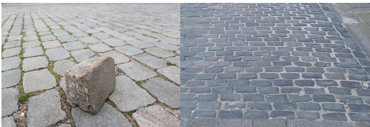
À gauche, des pavés sciés ; à droite, le revêtement traditionnel de la rue du Miroir, pavés originels taillés
