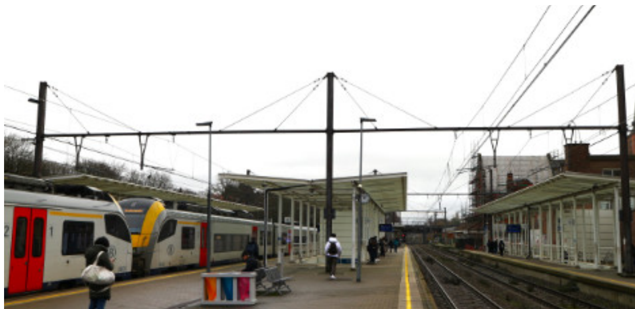
La gare de Jette. Source © ARAU
