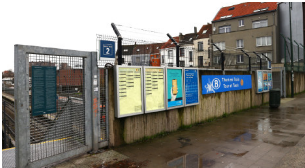
La gare de Tour et Taxis. Source © ARAU
