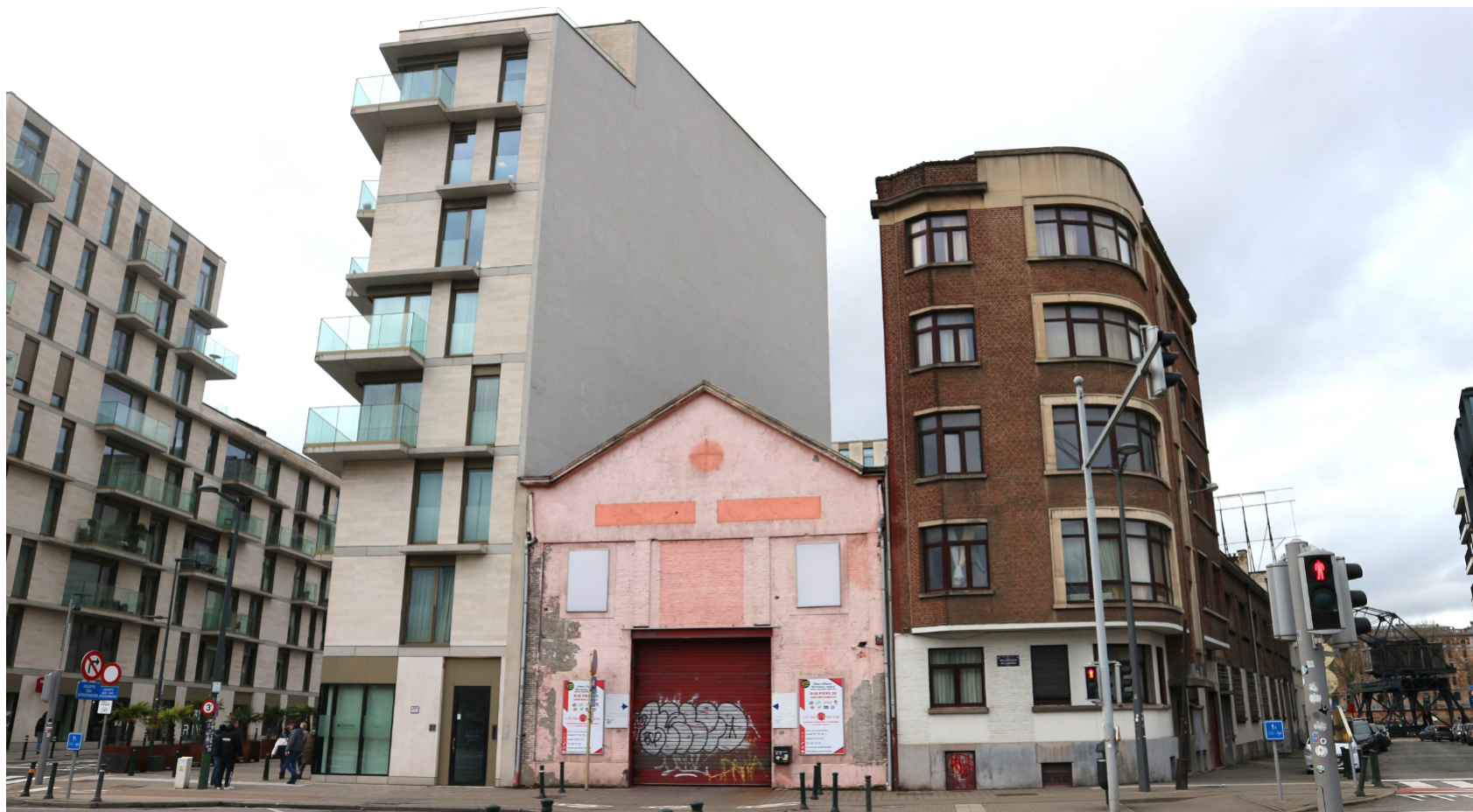
Les bâtiments existants quai de Willebroek et rue de la Dyle
